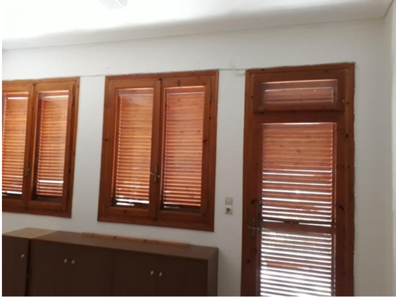
Εικόνα 6: Ανοιγόμενα ξύλινα κουφώματα με μονό υαλοπίνακα
